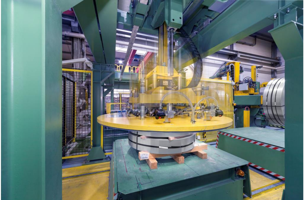
Die beim Absenken der Last erzeugte Bremsenergie wird mit einem KCM-Modul von KOLLMORGEN zwischengespeichert.
